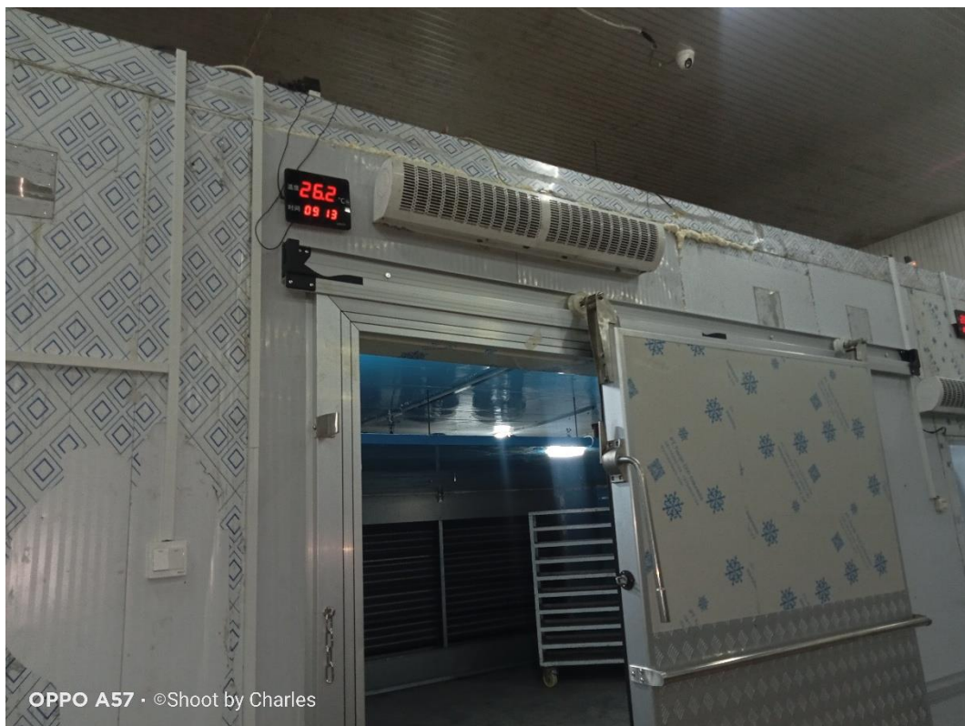
Gambar 4.8. Mesin Blast Freezer untuk membekukan santan kelapa.
