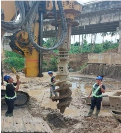
Gambar 4. 17 Penghancuran dengan Alat Auger [11]
