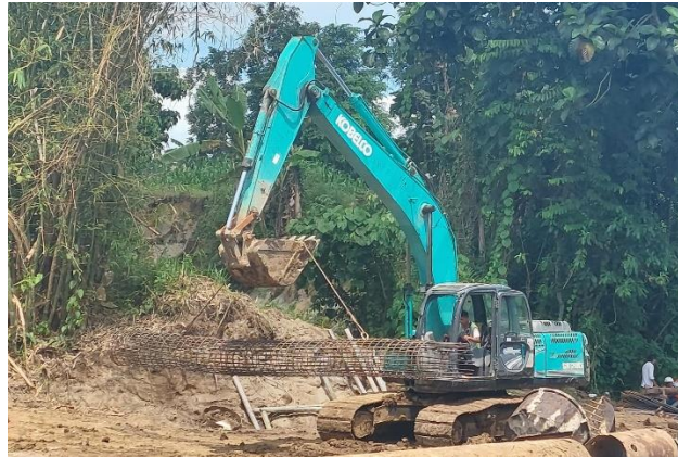
Gambar 4. 29 Pengangkatan Besi dengan Crane [11]
