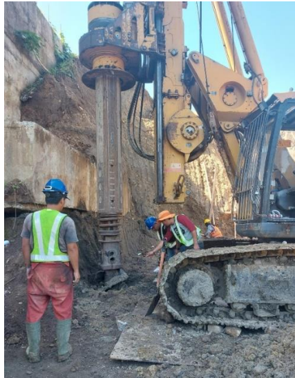
Gambar 4. 25 Pengeboran dengan mata bor Auger [11]
