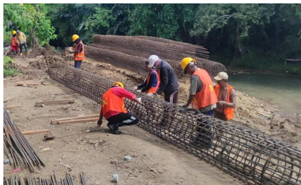
Gambar 4. 24 Pembuatan Keranjang besi [11]
