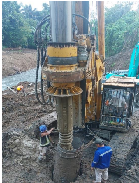
Gambar 4. 20 Masuknya Casing di dalam tanah [11]
