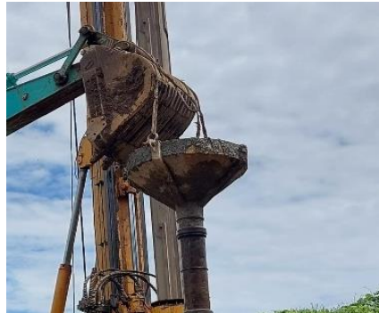
Gambar 4. 33 Pipa Tremie disambungkan dengan Corong [11]
