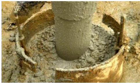
Gambar 4. 38 Selesai Pengecoran [11]
