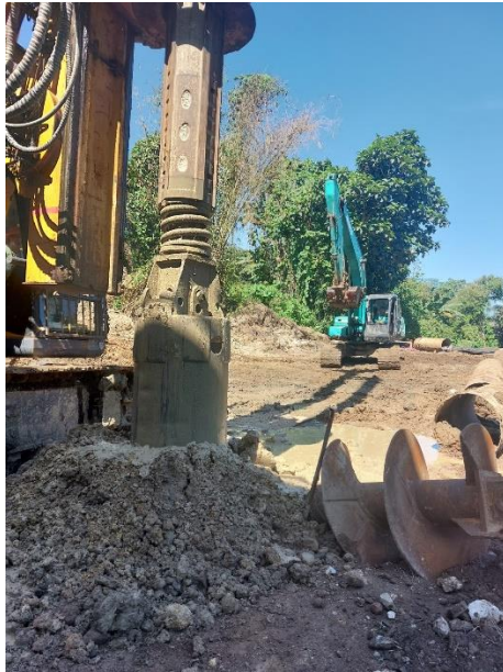
Gambar 4. 27 Pembuangan tanah lumpur [11]
