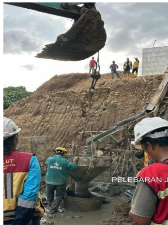
Gambar 4. 35 Mulai Pengecoran [11]
