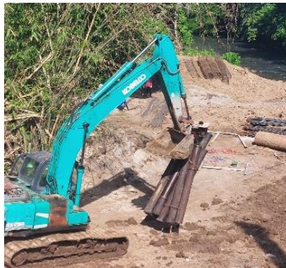
Gambar 4. 32 Pengangkutan Pipa Tremie [11]
