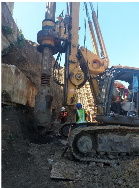
Gambar 4. 26 Pengeboran dengan mata bor Drilling bucket [11]
