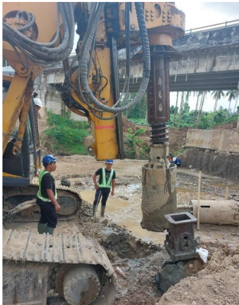
Gambar 4. 28 Melakukan Cleaning [11]
