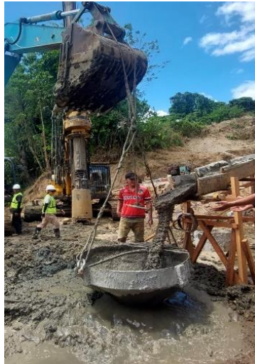
Gambar 4. 37 Masuknya Campuran Beton ke dasar tanah [11]
