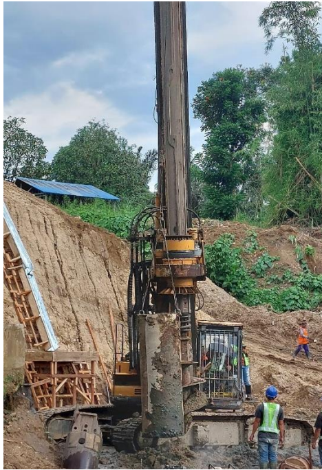
Gambar 4. 19 Pengangkatan Casing [11]
