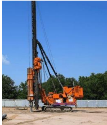
Gambar 3. 9 Pondasi Bored Pile Mini Crane [7]
