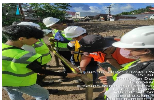
Gambar 4. 20 Pengukuran titik pancang dari titik simpan
