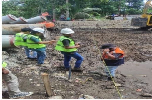
Gambar 4. 21 Pengukuran titik pancang dari titik ke titik
