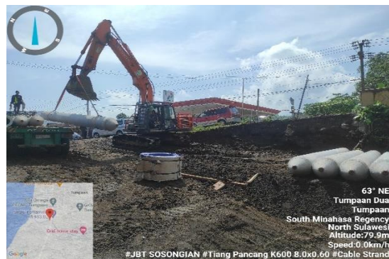
Gambar 4. 14 Pengangkatan tiang pancang menggunakan excavator
