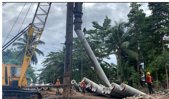
Gambar 4. 22 Pengangkatan tiang pancang
