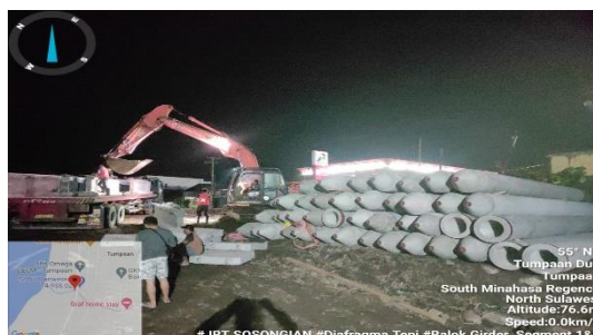
Gambar 4. 18 Penumpukan material di lokasi proyek
