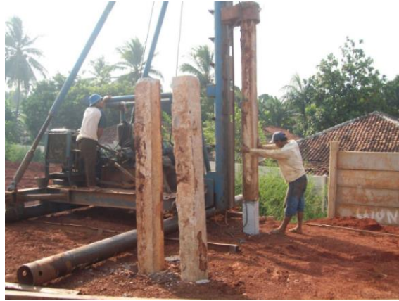
Gambar 3. 1 Tiang pancang kayu
