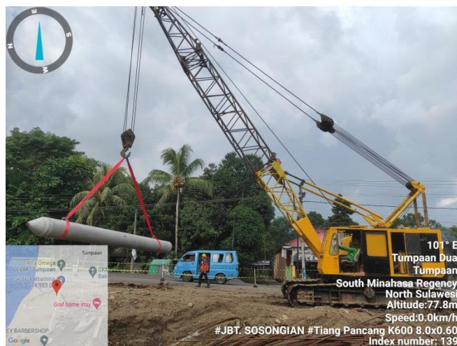
Gambar 4. 4 Pengangkatan Tiang Pancang [4]
