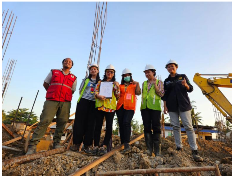
Gambar E- 2 Pengecoran
