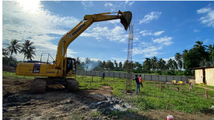
Gambar 4. 24 Instalasi besi tulangan pada lubang bor
