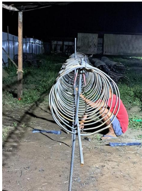
Gambar 4. 23 Fabrikasi perakitan besi tulangan
