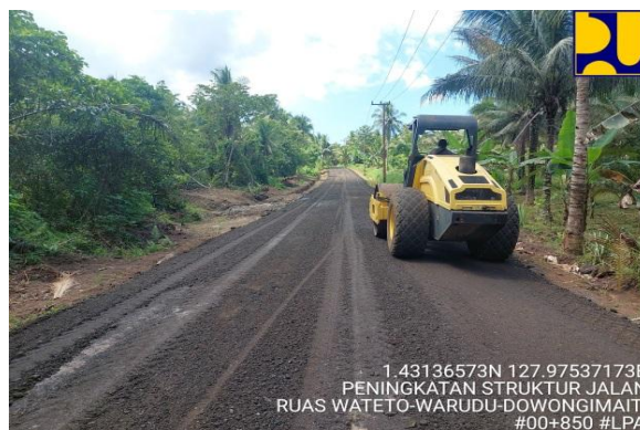
Gambar 4. 8 Pelaksanaan Pekerjaan Pematatan [2]
