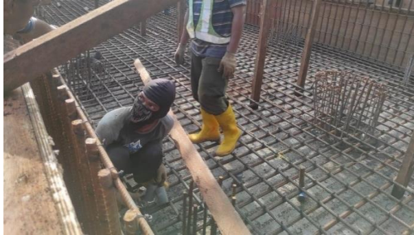
Gambar 3.9 Peletakan Beton Decking
