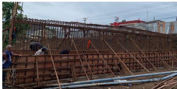
Gambar 3.8 Peletakan Pembesian Yang Telah Di Pabrikasi
