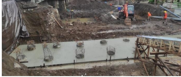
Gambar 3.6 Pengecoran Lantai Kerja
