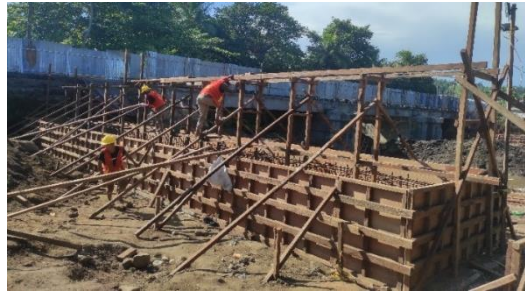
Gambar 3.7 Pembuatan Papan Mal Cetakan Pile Cap
