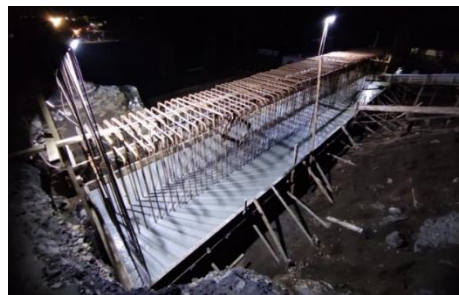
Gambar 3.10 Pengecoran Pile Cap
