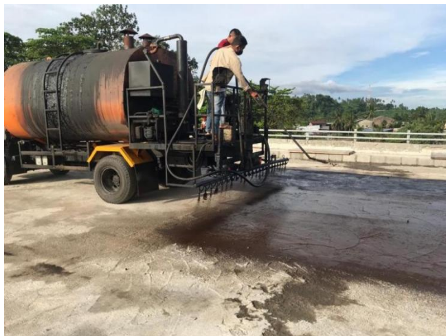
Gambar 4. 18 Kondisi lapangan plat lantai 50m tahap II [5]
