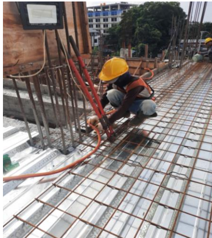
Gambar 3. 4 Pemasangan Wire Mesh
