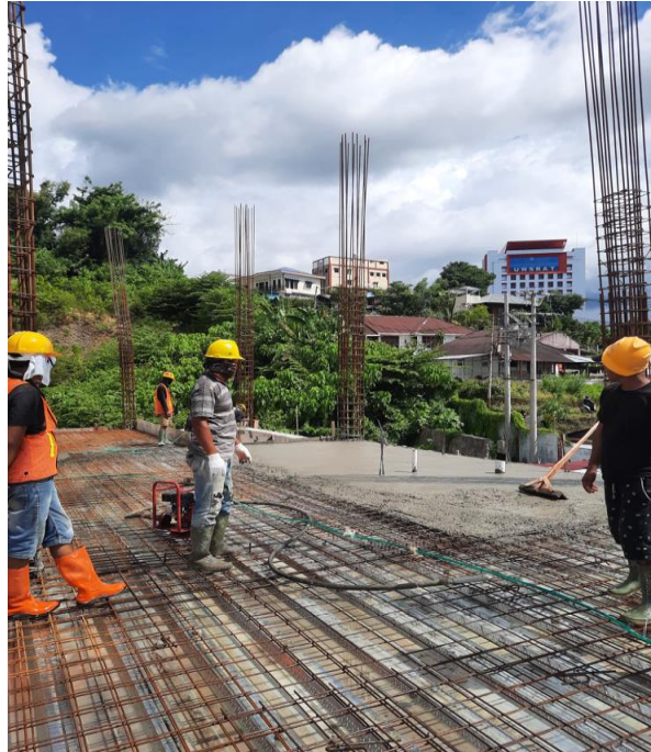
Gambar 3. 5 Pengecoran Plat Lantai 2
