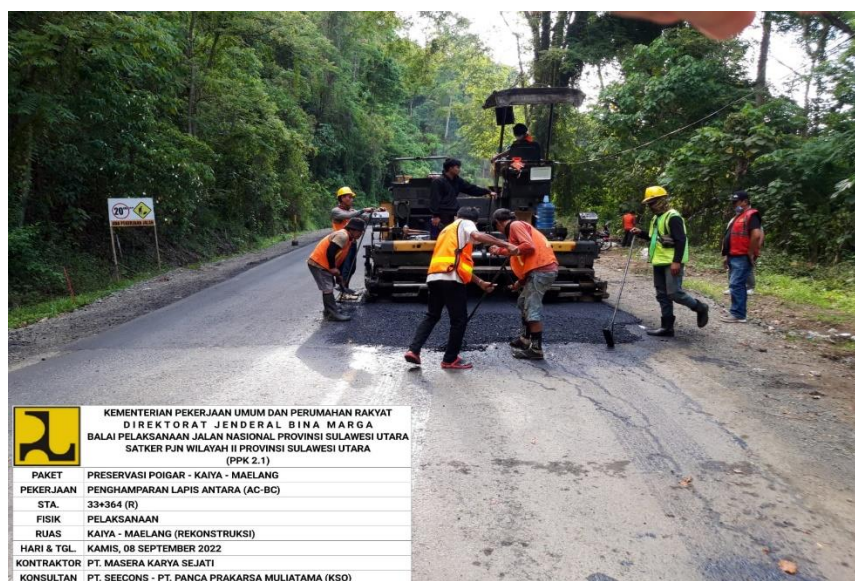
Gambar 4. 2 Penghamparan dengan Asphalt Finisher
