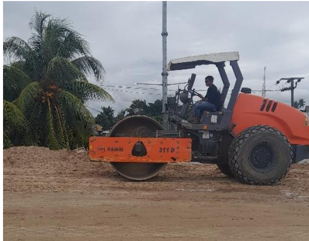
Gambar 4.3 Pemadatan Pada Material Timbunan Pilihan
