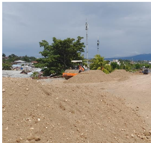
Gambar 4.1 Material Timbunan Pilihan
