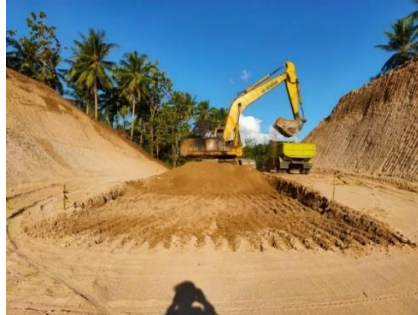
Gambar 4.6 Mengangkut Tanah di Dump Truck
