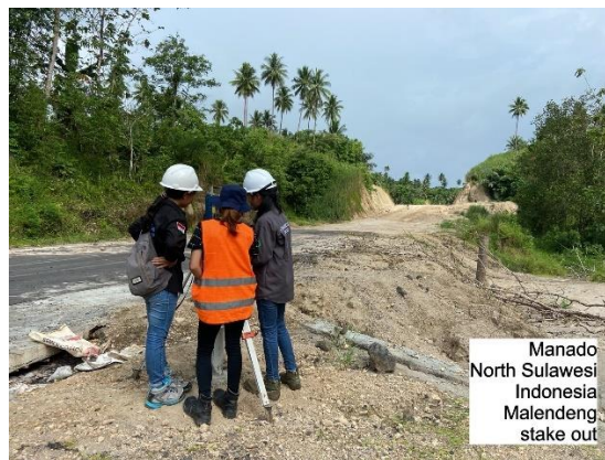
Gambar Pekerjaan Stake Out
