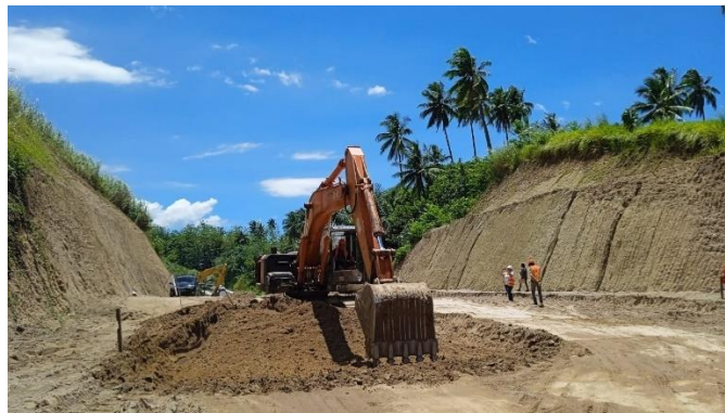
Gambar Pekerjaan galian STA 0+ 200
