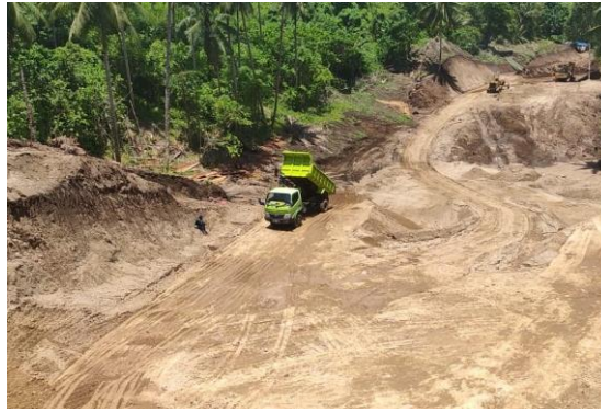
Gambar Pekerjaan penimbunan STA 0+550
