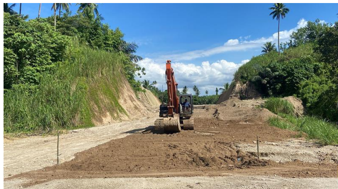
Gambar Pekerjaan galian STA 0+100
