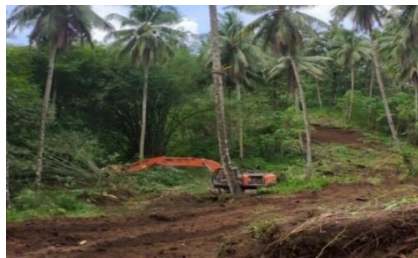
Gambar 4.4 Pekerjaan Land Clearing
