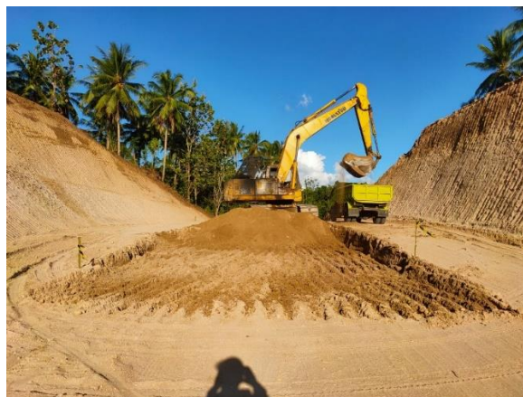
Gambar pekerjaan Galian STA 0+ 600
