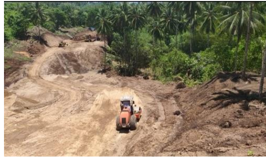
Gambar 4.11 Vibro Compactor Memadatkan Timbunan
