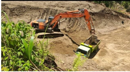
Gambar 4.8 Mengangkut Tanah di Dump Truck
