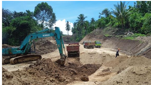
Gambar 3.4 Mempersiapkan Area Kerja
