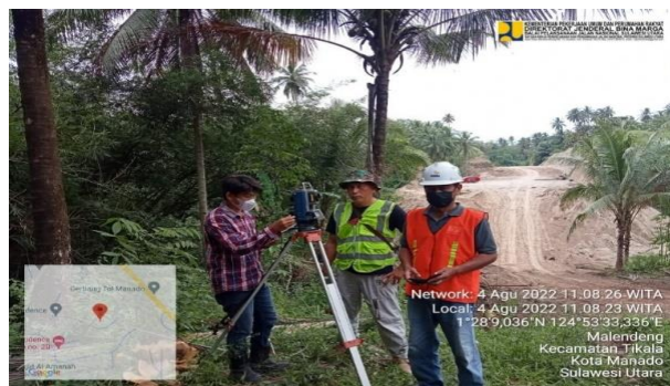
Gambar 4.1 Pengukuran Kontrol Horisontal
