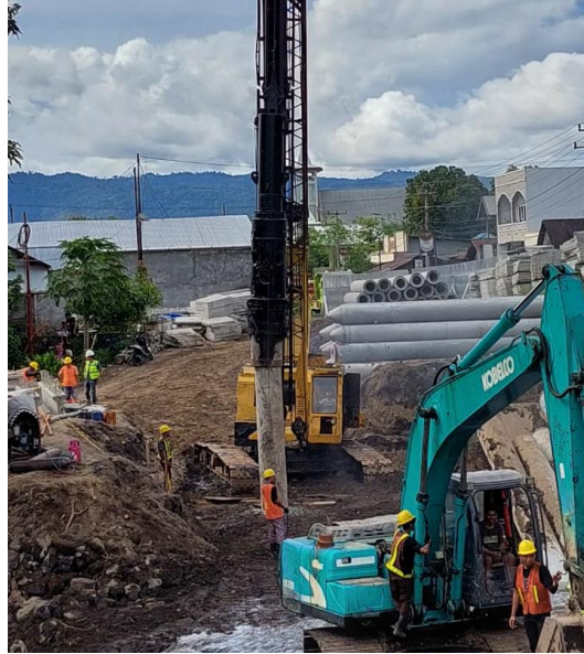
Gambar 4. 2 jarak alat pancang dan tiang listrik [6]
